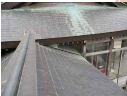
五十年を経て、劣化損傷の著しい銅板葺屋根
