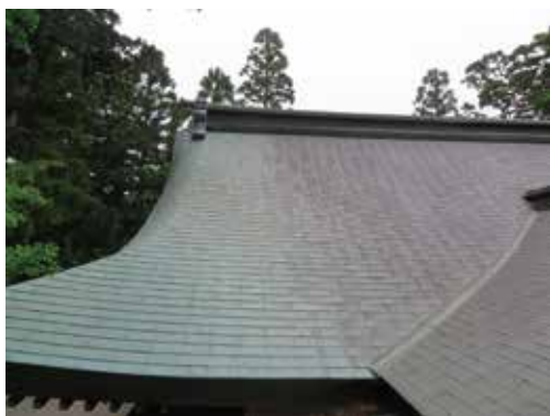
五十年を経て、劣化損傷の著しい銅板葺屋根
