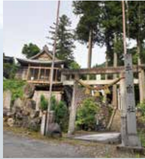
ガラスの風除室に守られる本殿
