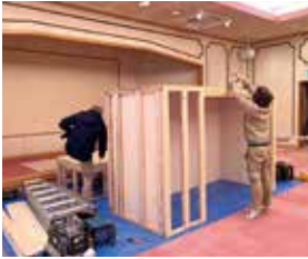
二月、遷座祭に向けて参集殿二階に設えの進む仮殿
