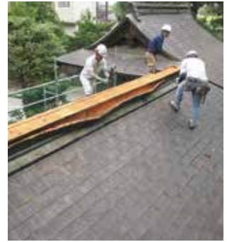
施工最初期。職人さんが回廊屋根の古い銅板をはがす
