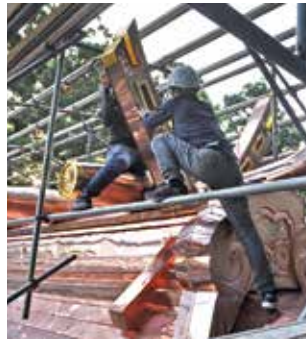
レック車により千木・鯉木を釣り上げての据え付け作業
