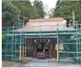
足場材に囲まれた功霊殿拝殿
